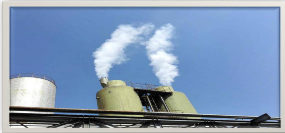
淀粉生产部二车间异味治理前的照片
