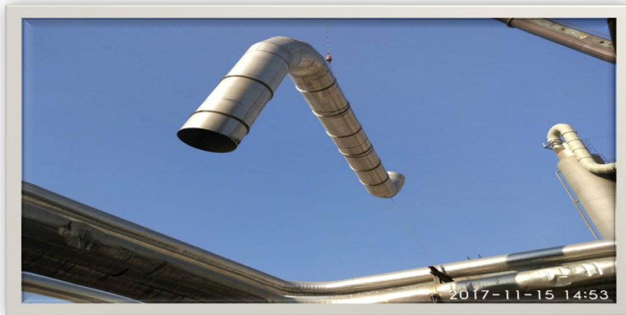
淀粉生产部一车间异味治理设施施工现场
